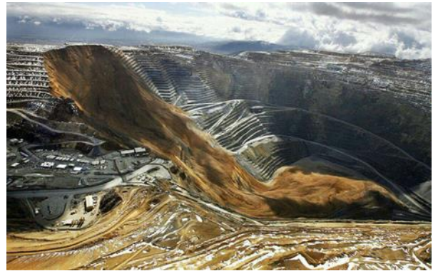
شکل ۱. تصویری از گسیختگی دامنه سنگی معدن مس
