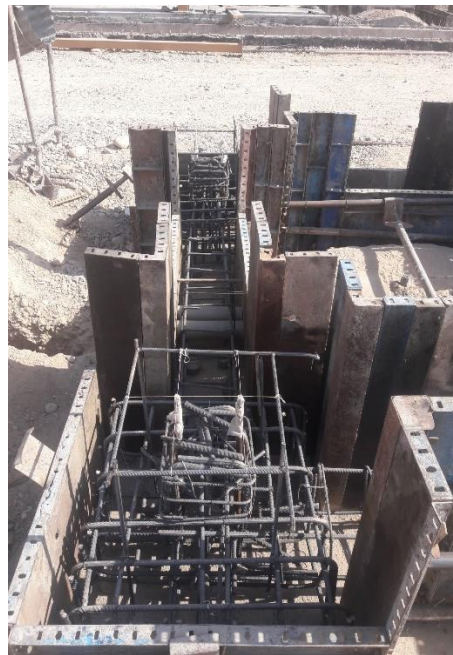
شکل ۴. پی نواری اجرا شده در پتروشیمی مارون طرح تولید پروپیلن
