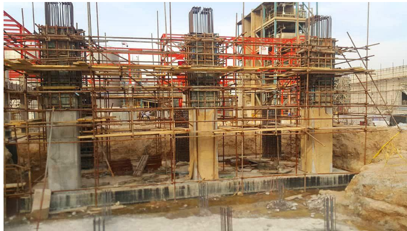
شکل ۳. پی گسترده اجرا شده در پتروشیمی کارون طرح HY CO
