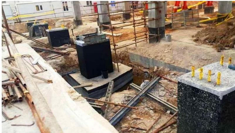
شکل ۲. پی منفرد اجرا شده در پتروشیمی کارون طرح HY CO
