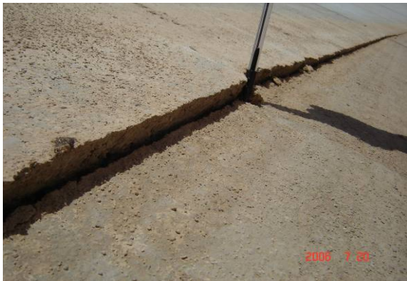
شکل ۴ - تصاویری از محل های آسیب دیده و شکل شماتیک بالازدگی پوشش
