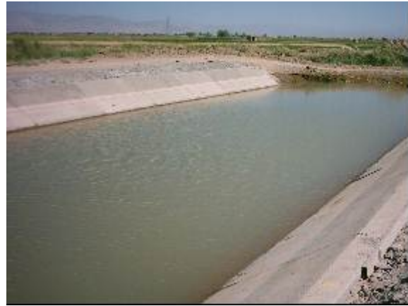
شکل ۷- بخشی از کانال که آب اندازی شده است
