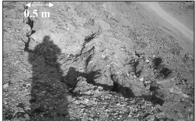
شکل ۱۴: نمونه‌ای از لغزش توده‌های شیلی در دیواره شمالی معدن گلبینی ۲ جبهه کار ۱
