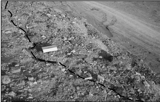
شکل ۱۵: نمونه‌ای از لغزش توده‌های شیلی در دیواره شمالی معدن گلبینی ۲ جبهه کار ۲
