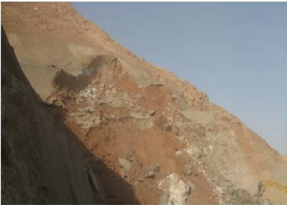
شکل ۳. لغزش قاشقی در شیروانی مشرف به دهانه خروجی
