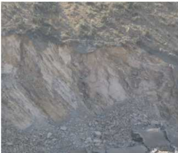
شکل ۳. لغزش قاشقی در شیروانی مشرف به دهانه خروجی
