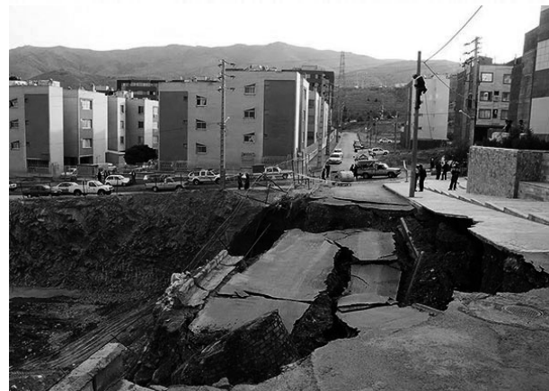
شکل ۱. بالا: نمونه ای از یک لغزش بزرگ انتقالی و تخریب یک مجتمع در حال ساخت در خیابان هاشمیه (سال ۱۳۸۵)؛ پایین: ریزش حاصل از گودبرداری در سنگ های اولترابازیک خیابان هاشمیه (سال ۱۳۹۲)
