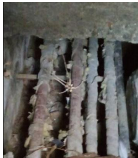
شکل ۱۳. نمایی از لوله‌های فلزی مدفون در زیر سطح زمین در مجاورت یکدیگر درون یک کانال در محدوده برداشت.
