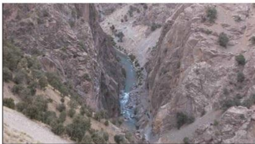
شکل ۲. نمایی از ساختگاه سد رودبار لرستان
