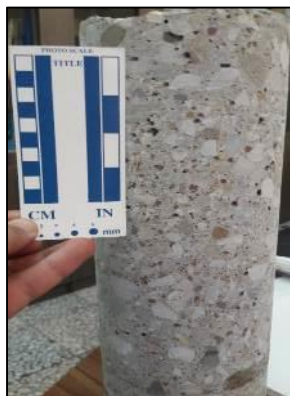
شکل ۶. مغزه از بتن سرریز سد کرخه
