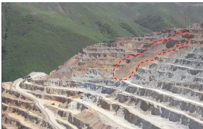
شکل ۷. نمایی از ناپایداری رخ داده در بخش جنوبی معدن در سنگهای سست آذرآواری (دید عکس به سمت جنوب شرقی)
