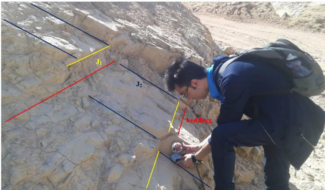
شکل ۴. ناپیوستگی‌های موجود در ساختگاه سد مسجد سلیمان
