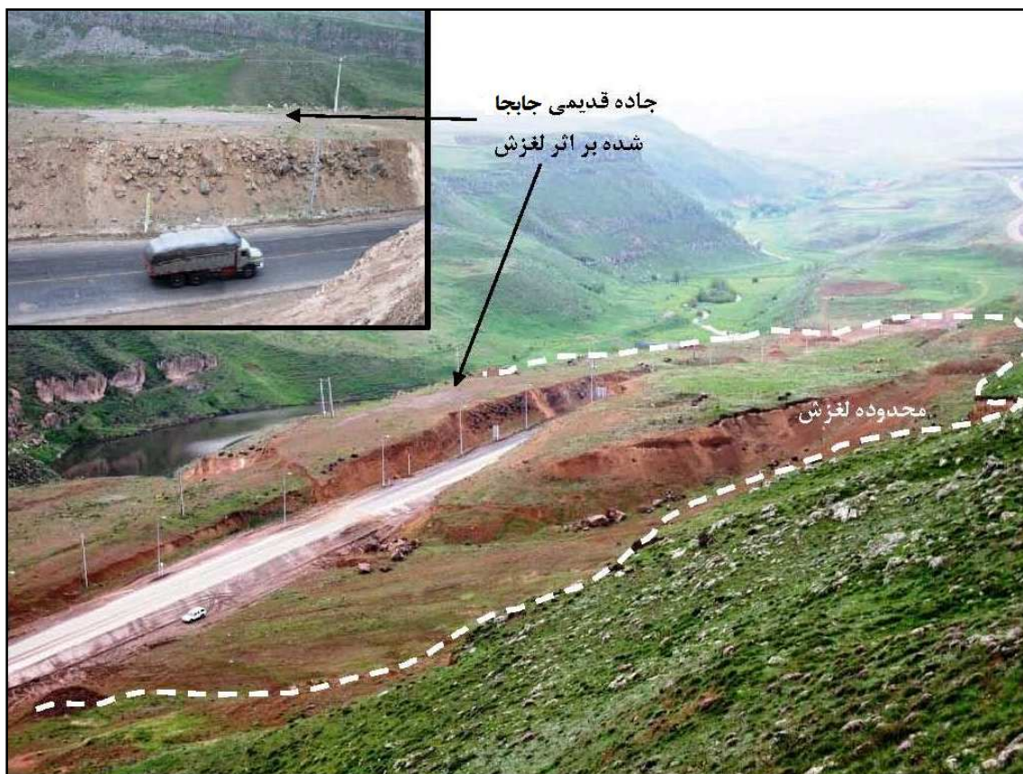
شکل ۷. محدوده لغزش و مکان جاده قدیمی و جدید در محل لغزش (نگاه به سمت جنوب).
