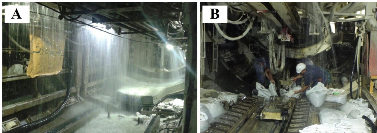
شکل ۱۲. A- ریزش مصالح سنگی حفاری به همراه جریان شدید آب از روی نوار نقاله. B- تمیزکاری و جمع‌آوری مصالح سنگی ریخته شده از روی نوار نقاله.
