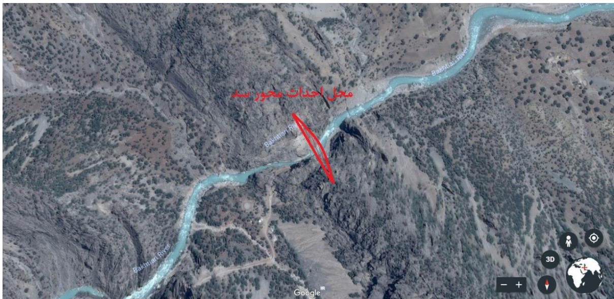
شکل ۴. تصویر هوایی از محل احداث محور سد در آهک‌های تله‌زنگ
