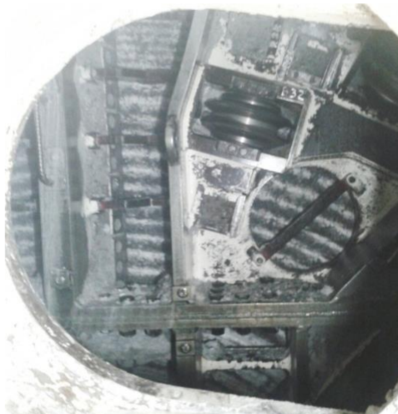
شکل ۵. دید از دریچه چمبر - نمایی از وضعیت ژئومکانیکی سینه‌کار حفاری، کیلومتر ۰+۴۹۰ در سنگ بکر انیدریت*.
