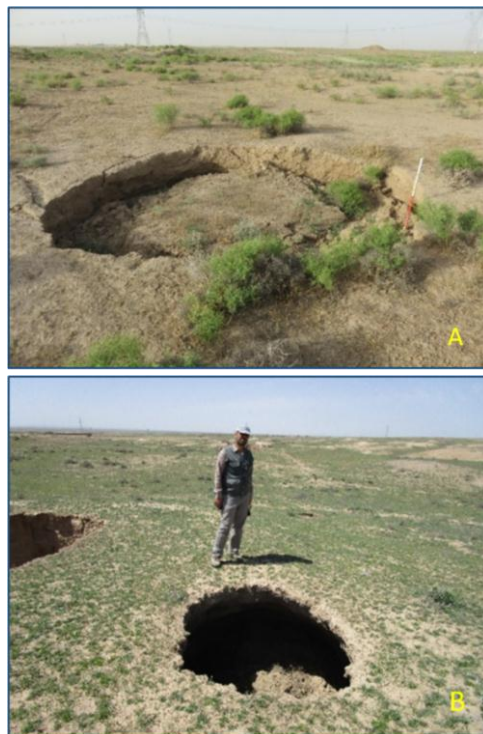
شکل ۴. A: شکاف‌های نوع دوم در شمال روستای کاریزک
