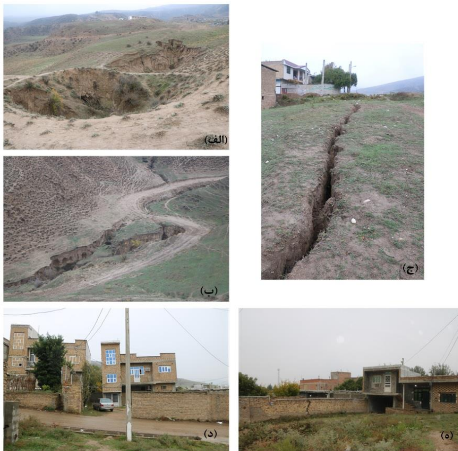
شکل ۱. خطرات ناشی از گسترش لس ها در استان گلستان الف) فروچاله در روستای چشمه لی ب) گسترش فرسایش خندقی در روستای چشمه لی ج) ترک خوردگی زمین در شهر فراغی د) نشست نامتقارن ساختمان مسکونی در شهر فراغی ه) ترک خوردن دیوار منازل مسکونی در شهر فراغی
