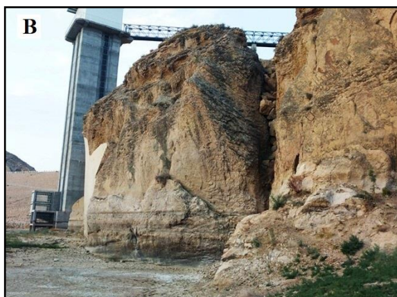
شکل ۵. درزه ها و شکستگی های جناح راست بالادست سد ایبورد (A)-درزه های موازی با محور چین (J2)، و B-درزه های عمود بر محور چین (J4).
