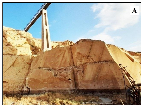
شکل ۵. درزه ها و شکستگی های جناح راست بالادست سد ایبورد (A)-درزه های موازی با محور چین (J2)، و B-درزه های عمود بر محور چین (J4).
