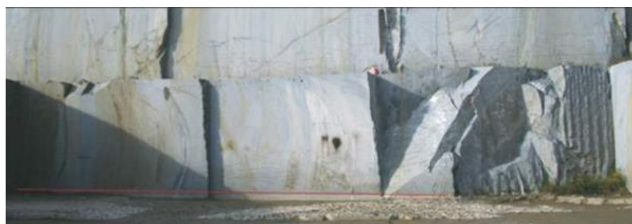
شکل ۱۲. ایجاد و لغزش گوه سنگی در یک معدن سنگ تزئینی
