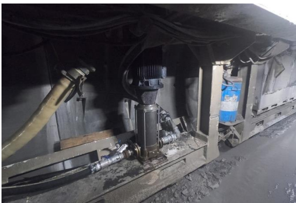
شکل ۲۴. نصب پمپ فشار قوی طبقاتی و ایجاد خط لوله جدید جهت استفاده از آب برگشتی سیستم خنک کننده برای شستشوی مصالح سنگی روی فیدر.
